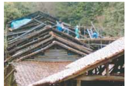
屋根の修復作業
