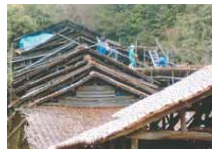
屋根の修復作業
