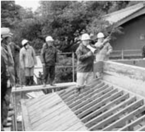
伝統工法の特徴を説明しながら解体しました
