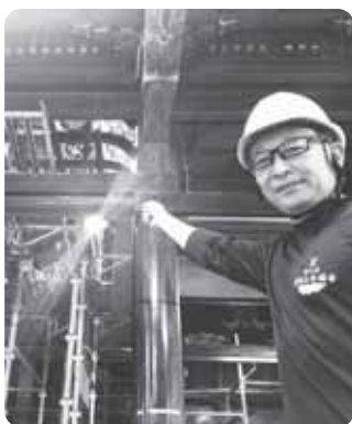
▲本堂内部の修繕の様子 西村住職
