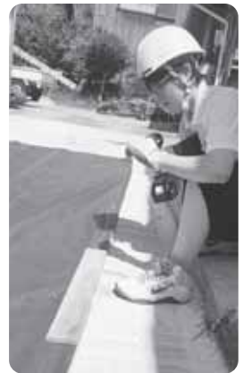
▲ブルーシート張り
