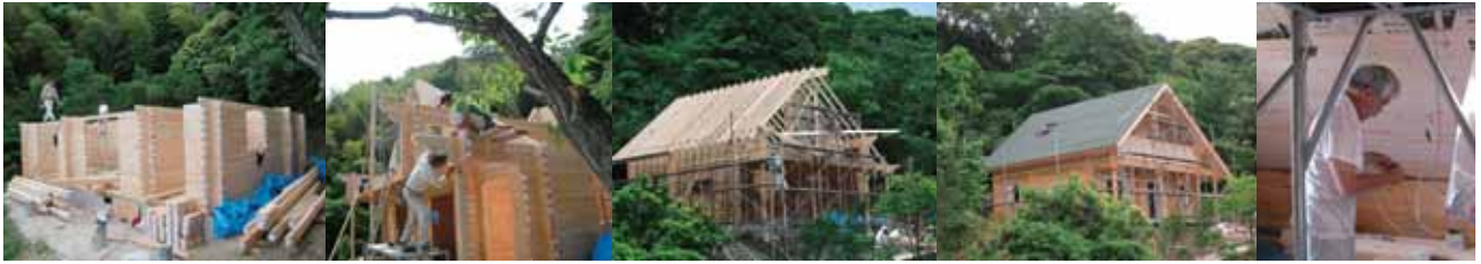
敷地が高台にあるため、資材の運搬は大変だったそう。基礎工事から棟上げまではプロに頼み、内部の仕上げ電気配線は第1種電気工事士の免許をもつ政喜さんが工事。自分でできる作業は全て自分の手で
