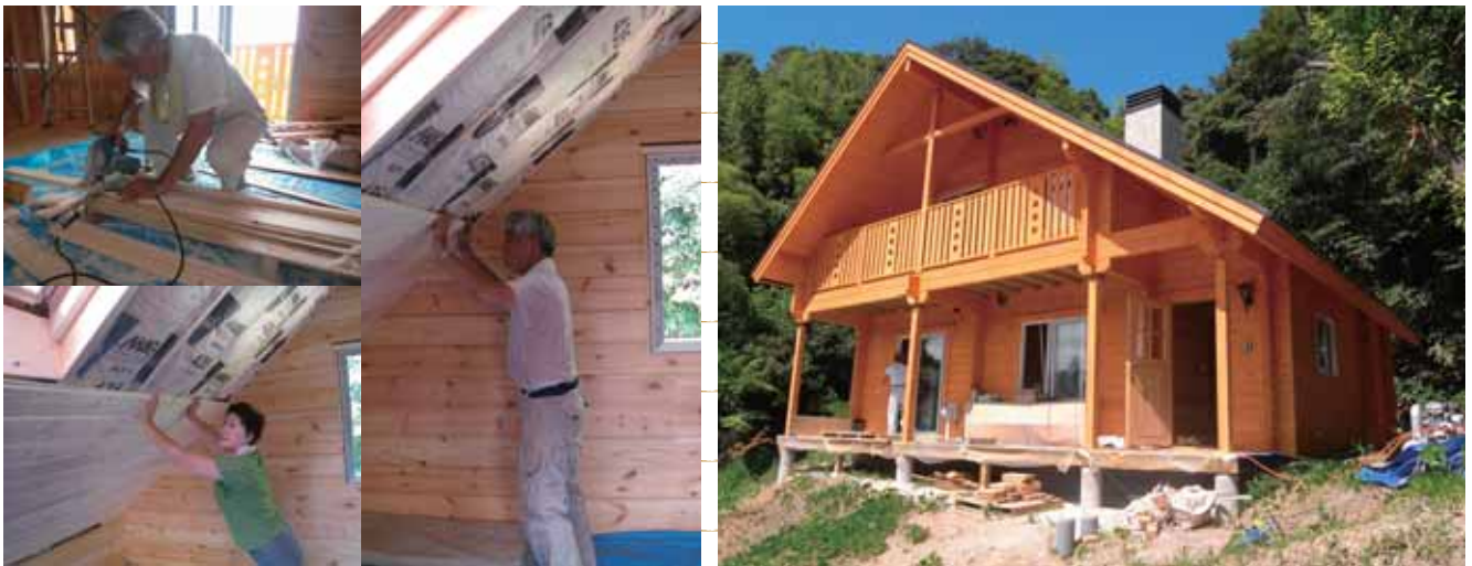
内壁を張る木材をカットし、夫婦二人での共同作業
