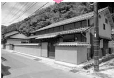
写真② 新築の修景例 (上：修景前、下：修景後)
