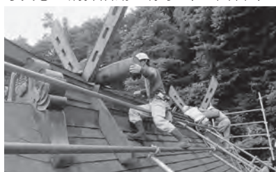
写真③ 保存修理の様子（城上神社）
