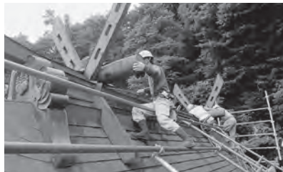
写真③ 保存修理の様子（城上神社）
