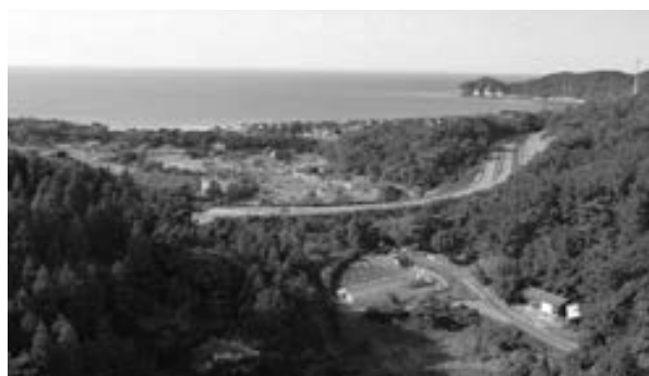
▲琴ヶ浜第一高架橋からの風景
